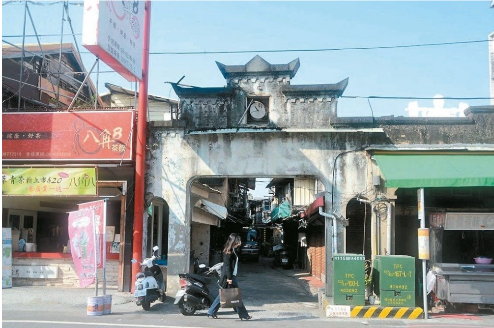
新營第二市場建立迄今已逾一甲子，因建物老舊危險，瀕臨被拆除的命運。 記者邵心杰 / 攝影
